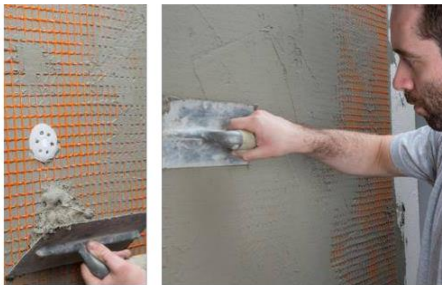
Figura 7. Applicazione malta rasante con annegamento rete d'armatura.
