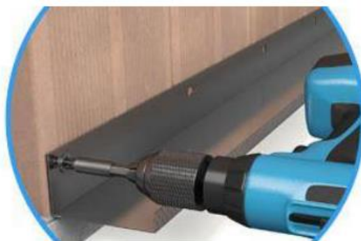
Figura 2. Fissaggio del profilo con i tasselli.
